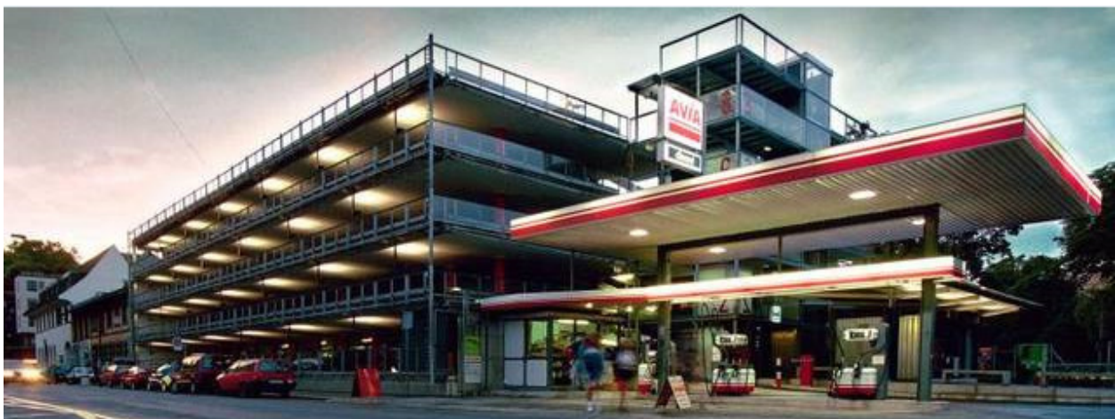
Parkhaus, Sihlquai, 8004 Zürich
